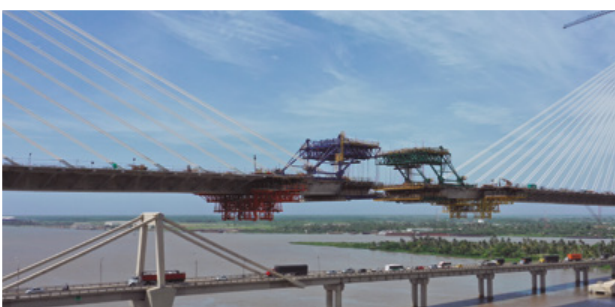
Figura 47. Ejecución de dovelas de 10m mediante carros de avance en vano principal.
