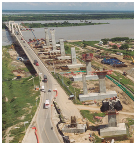
Figura 18. Alzado de fuste y capitel de las pilas de los vanos de acceso. Fustes pilas ejecutadas.
