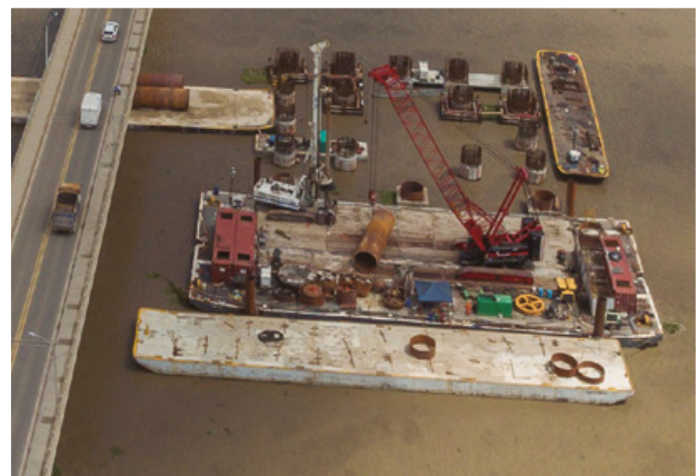
Figura 48. Ejecución pilotes encepado pilono P13 desde pontonas.
