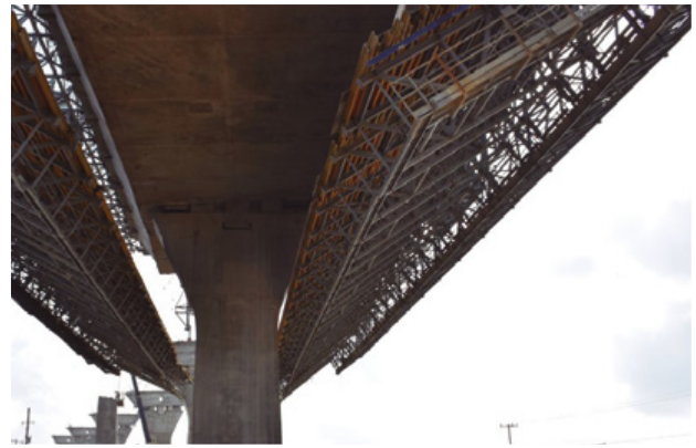
Figura 29. Autocimbra en avance a vano 21.
