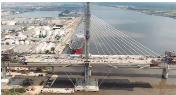
Figura 38. Llegada del brazo de retenida del tablero a la pila de retenida, en el que se aprecian los tirantes provisionales antiviento anclados en las dovelas 4 de cada lado.
