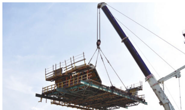
Figura 52. Flanqueo plataforma inferior carro de avance pila 12.
