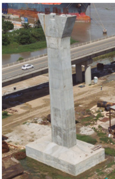
Figura 18. Alzado de fuste y capitel de las pilas de los vanos de acceso. Fustes pilas ejecutadas.
