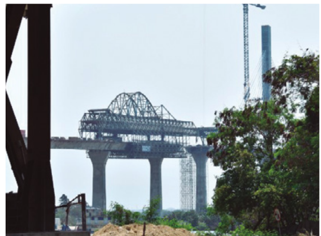
Figura 34. Punto fijo en margen derecha.
