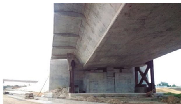
Figura 22. Puntos fijos provisionales en fase constructiva.
