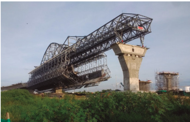
Figura 19. Proceso de ejecución de los viaductos de acceso con autocimbra (Foto: David Ruiz).
