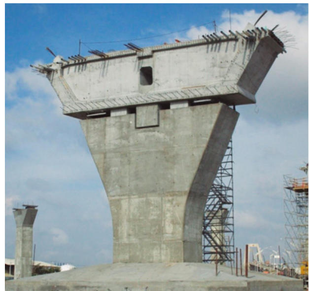
Figura 20. Mamparo con dados de hormigón provisionales y anclajes provisionales.
