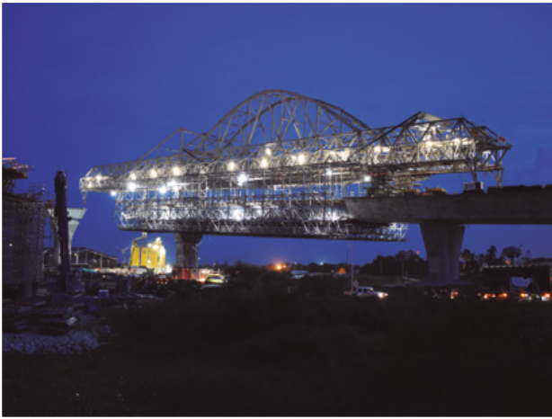
Figura 23. Autocimbra en posición de hormigonado.
