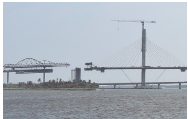
Figura 30. Autocimbra en avance a vano 11.
