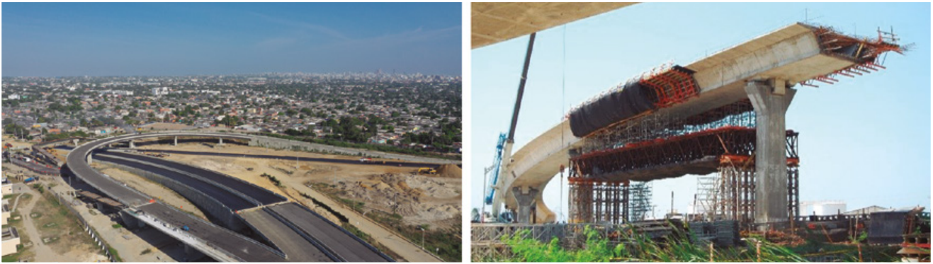
Figura 5. Izda: vista aérea del ramal sur. Dcha: el ramal norte durante su construcción.
