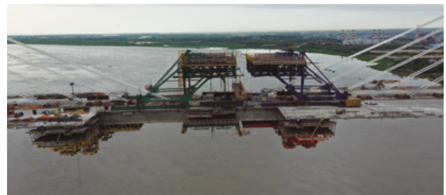
Figura 53. Vigas de continuidad en cierre vano principal.
