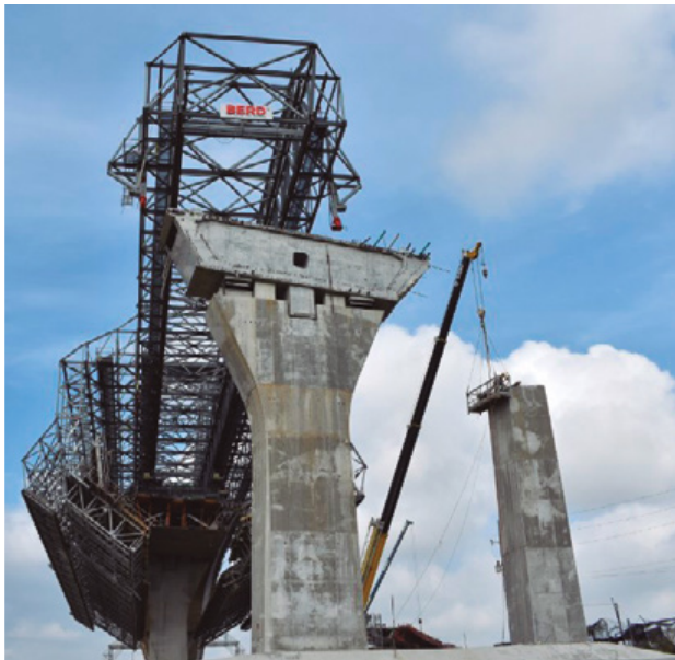
Figura 28. Autocimbra en avance a vano 21.
