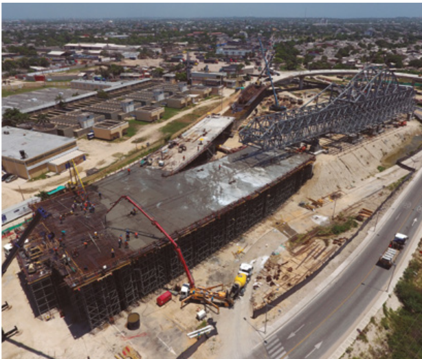
Figura 24. Montaje autocimbra en el lado Barranquilla.
