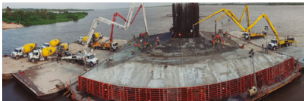
Figura 49. Hormigonado encepado pilono P13 desde pontonas.
