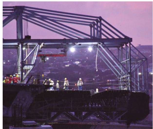
Figura 26. Carro de alas en viaductos de acceso.
